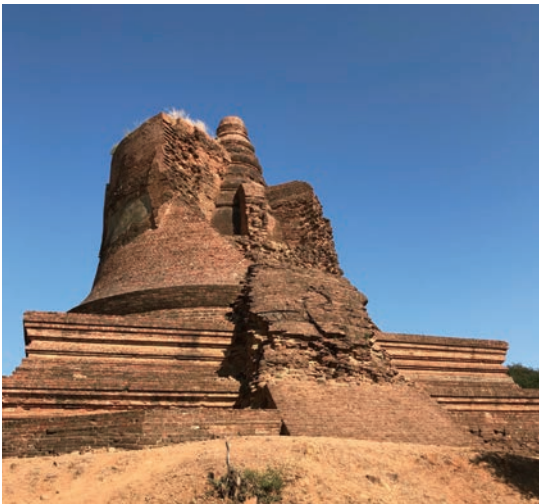
図 9 ストウパを内包するストウパ。 大型のストウパの崩壊部から、内部に異なる様式のストウパを包含していることを確認できる。 (No. 1158 : Kyauk Mye Mo Zedi Gyi)
