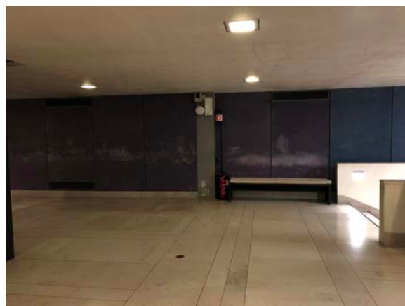
図7 1F 南東面 開口を塞いだ壁面
